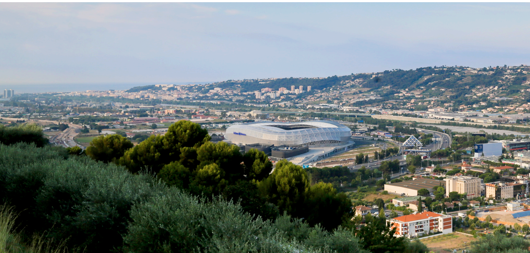
Aperçu de la zone en cours d'aménagement de la Plaine du Var.
