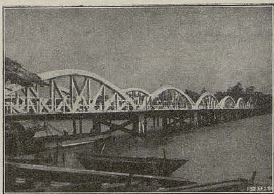
PONT SUR LA ROUTE DE REAM (CAMBODGE).
