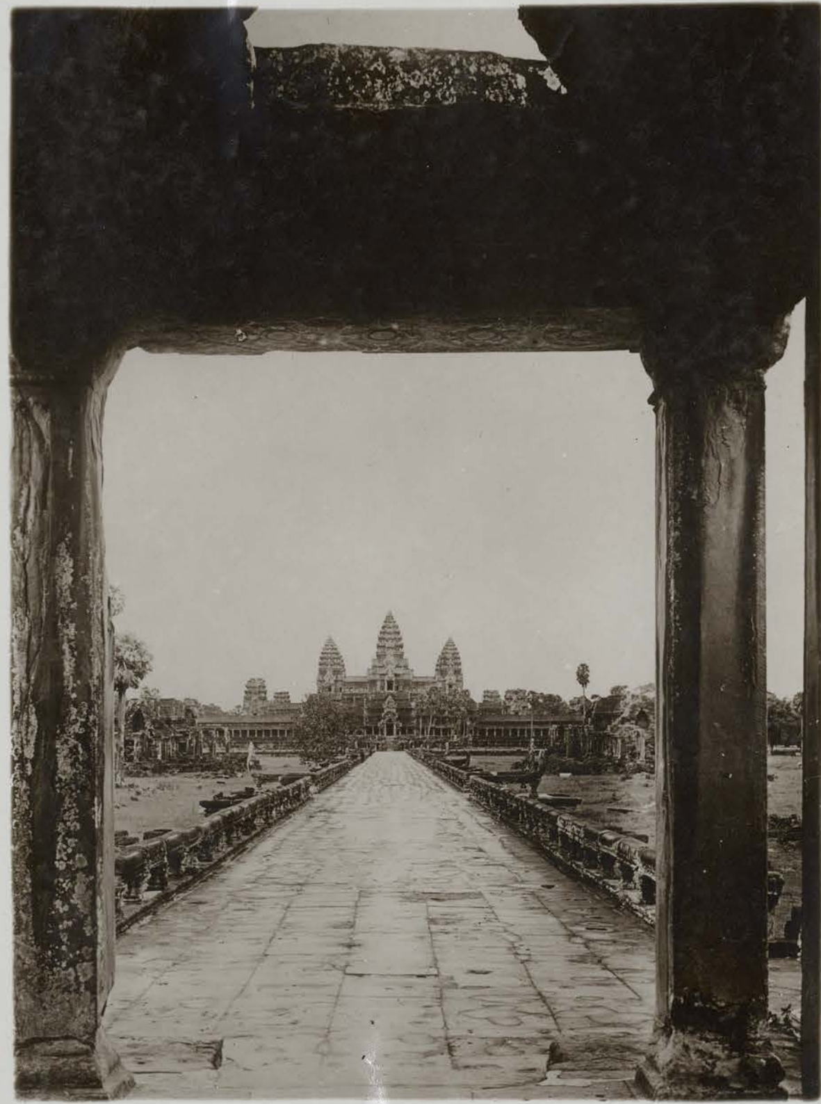
~ Vue générale prise du porche de la première galerie. ~
