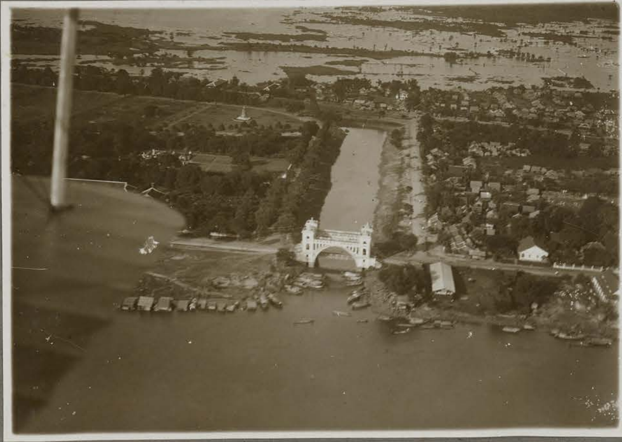
Pont du Dolard.
