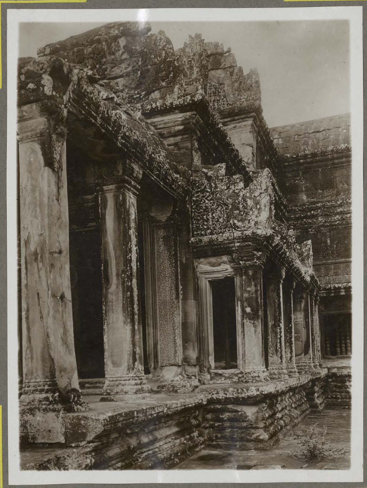
Corbeil central de la première galerie et détail de la toiture.
