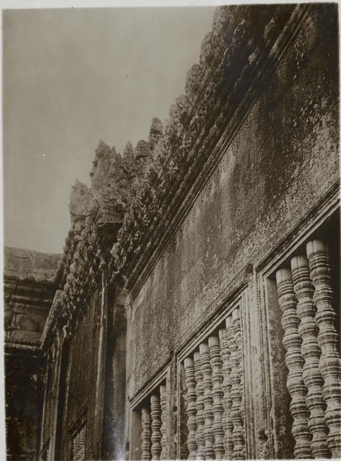
~ Façade de la première galerie Ouest (détail extérieur). ~
