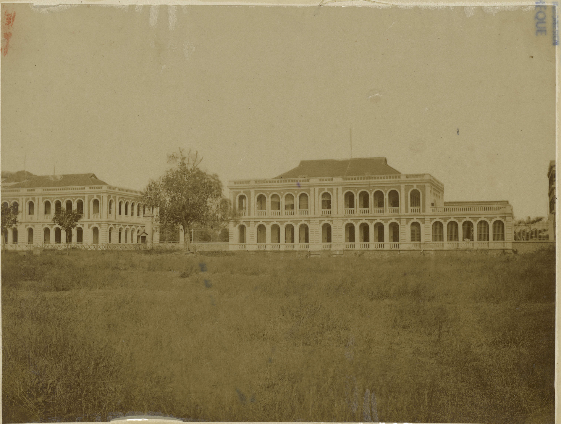
Tue des pavillons d'entrée de la Caserne d'Infanterie de la Marine (côté droit)
