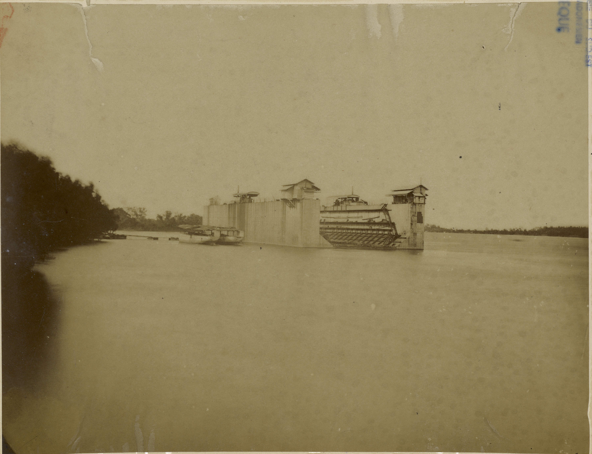
Vue du Bassin de Retention
