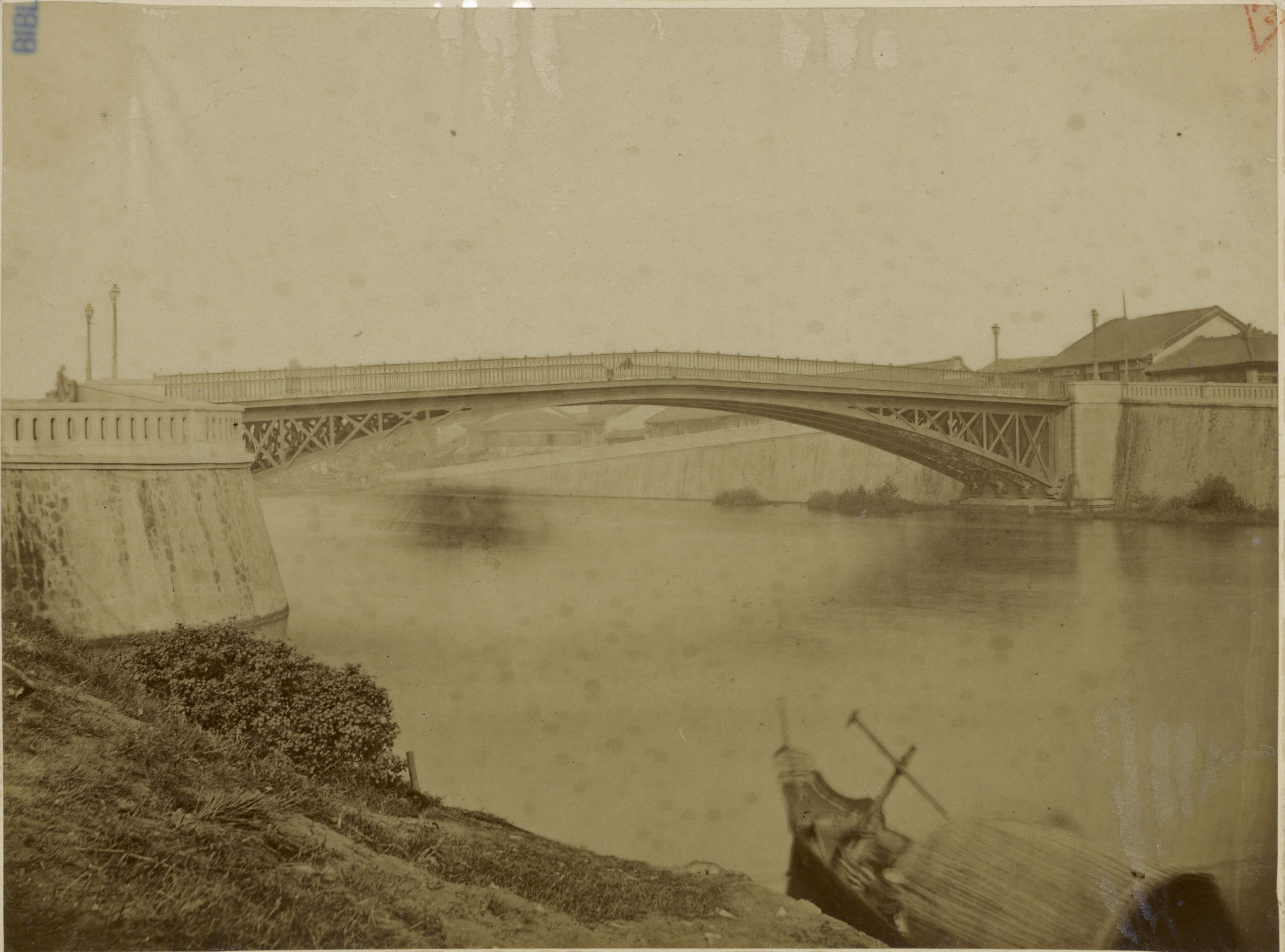
Rue de Cholon (Pont en fer)
