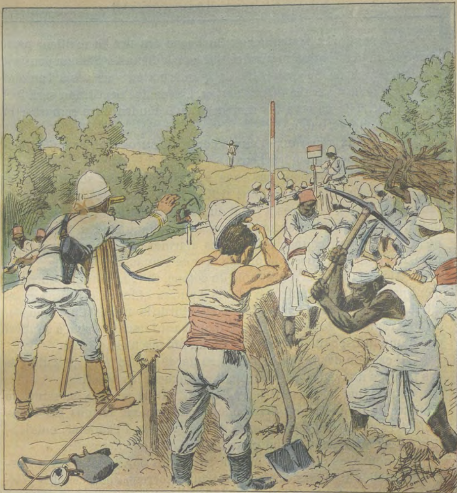
Construction d'une route par le génie.
