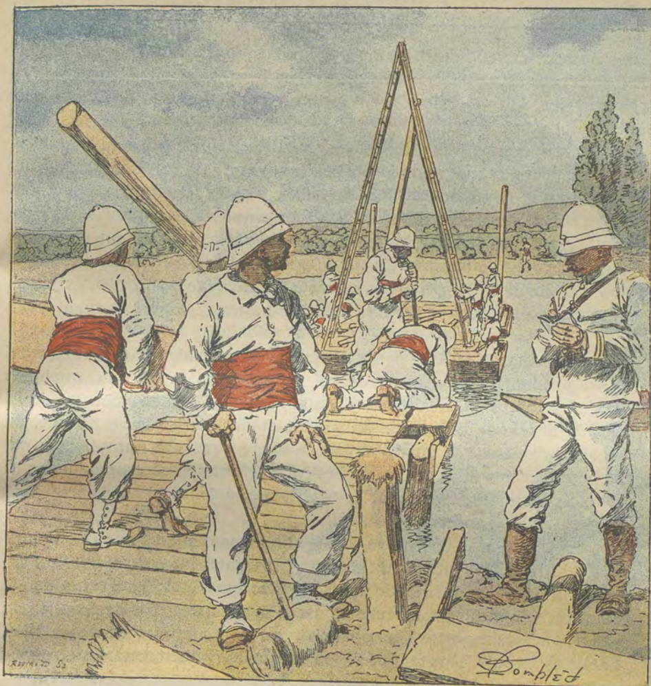
Construction d'un pont sur l'Ikopa.
