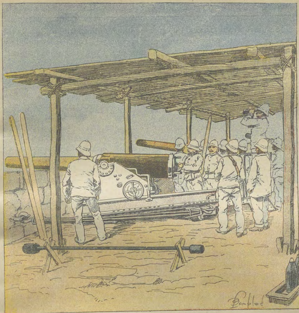
Batteries de pièces de 14 dans le fort de Tamatave.
