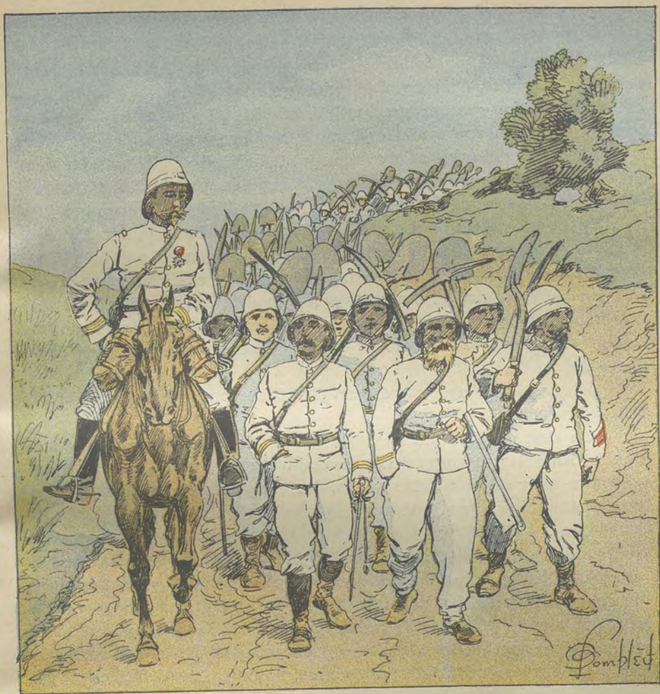
Construction de la route. Départ de la corvée.
