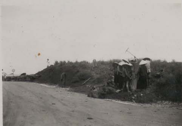
HANOI. Crue du 2-9-1954 (alerte 2) Travaux de comblement de la tranchée dans la digue.
