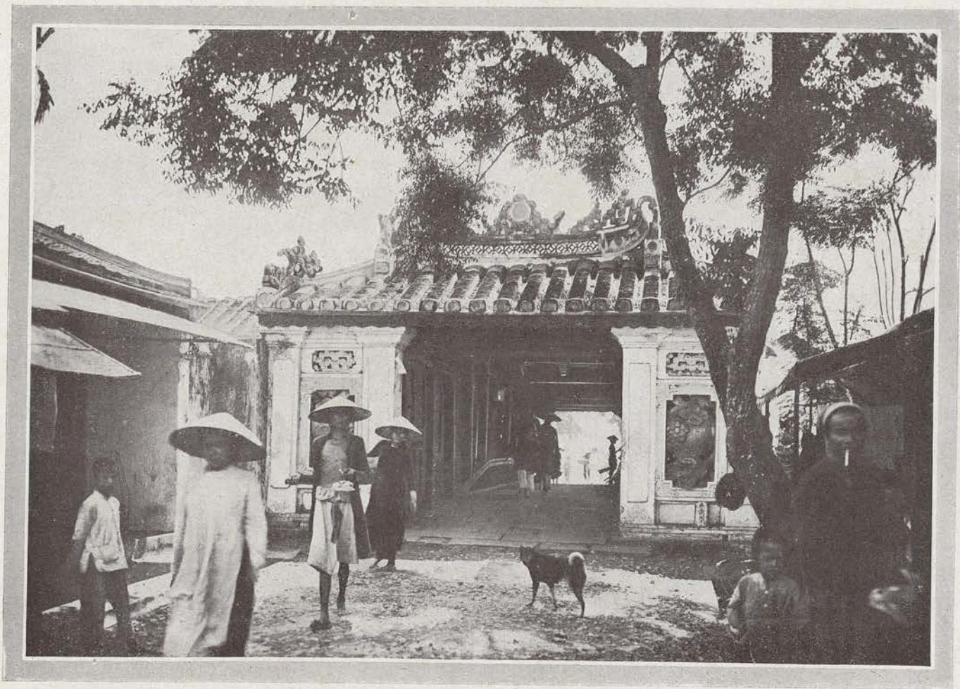
Pont couvert, dit pont japonais.
