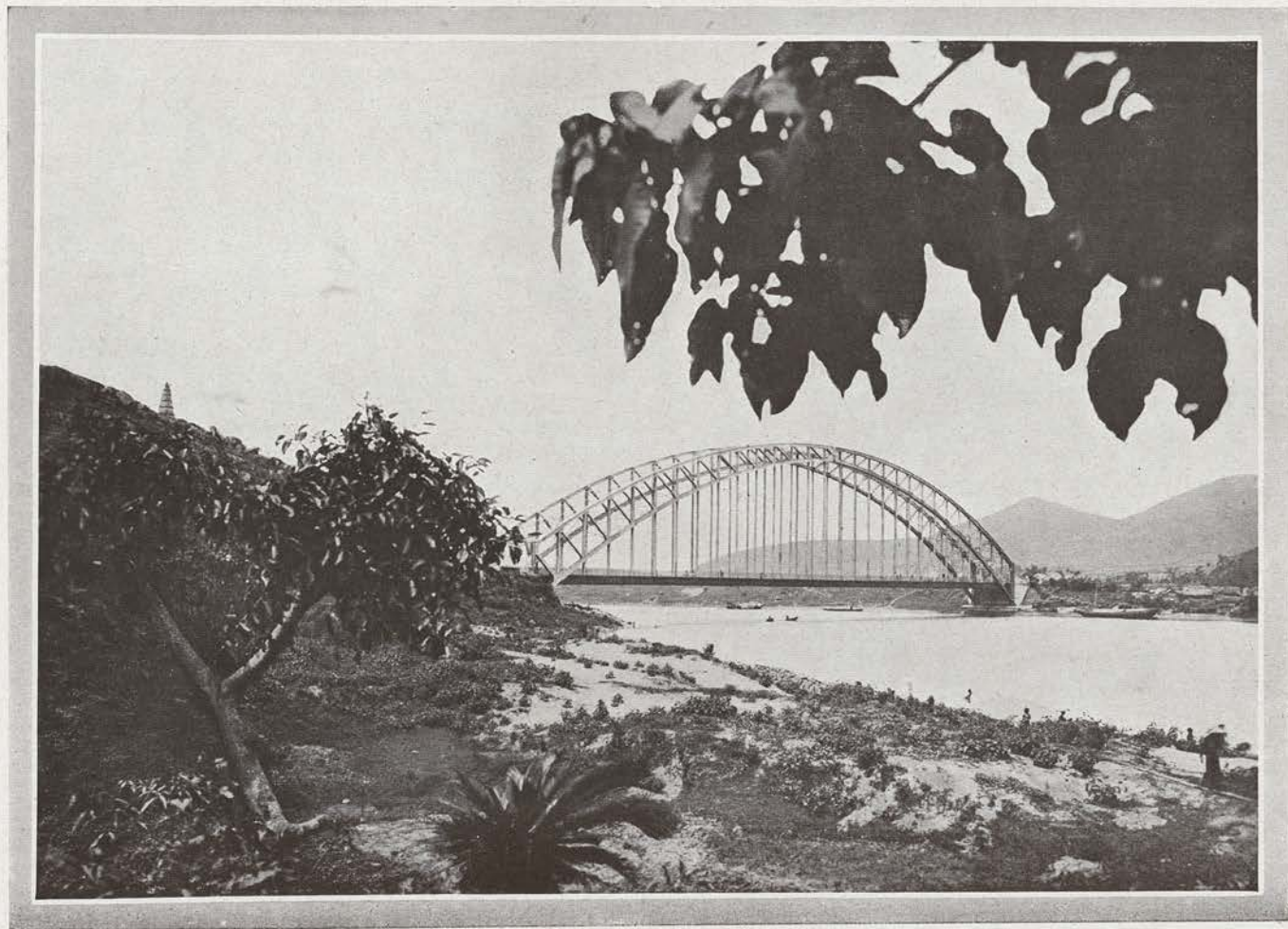
Du nord au sud à travers l'Annam. — Le pont d'Ham-Rong dans la province de Thanh-Hoa. Across Annam from North to South. — The bridge of Ham-Rong in the province of Thanh-Hoa.
