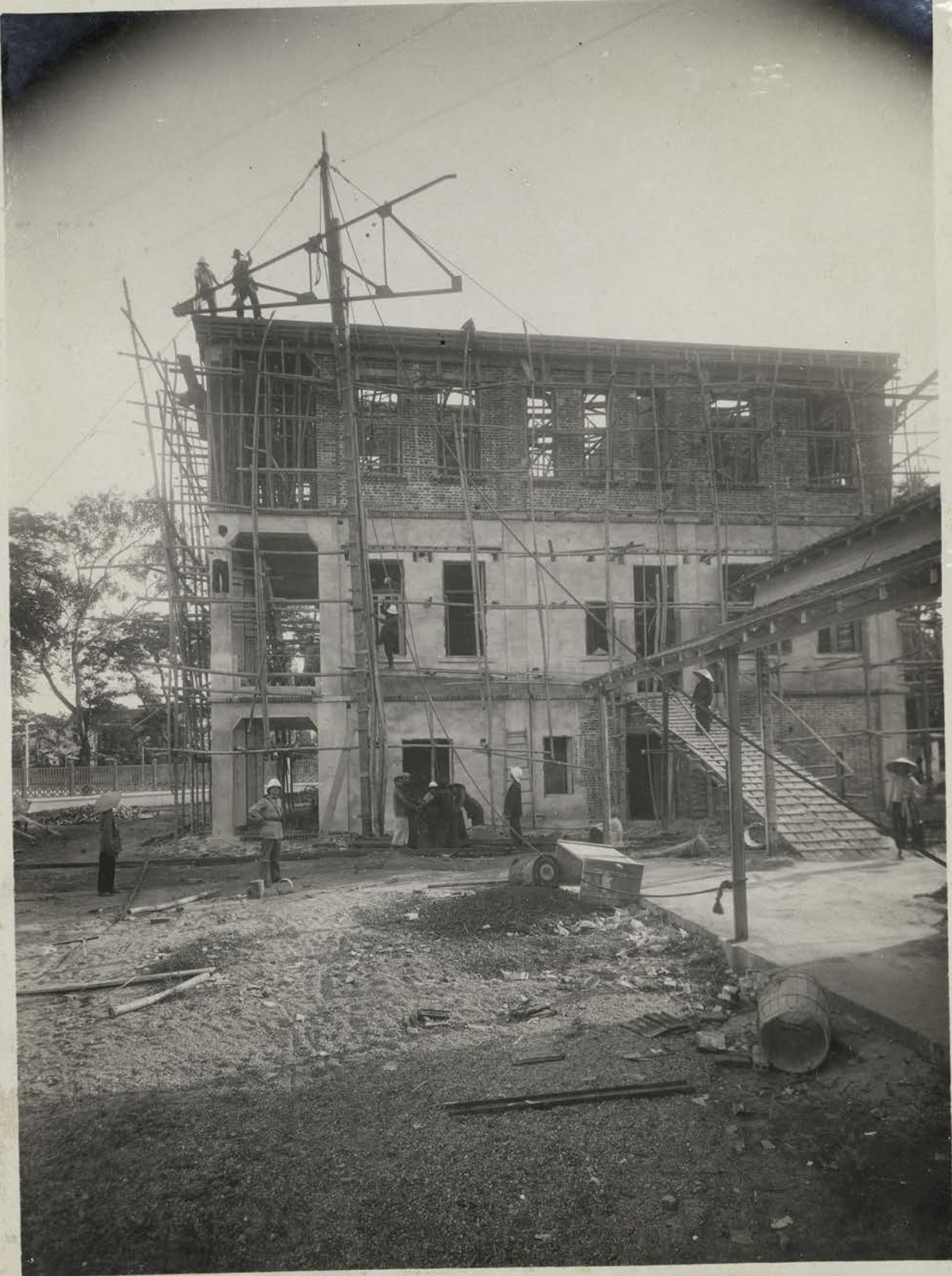
Le Batiment en COURS de CONSTRUCTION 8 et 9 Montage d'une Ferme .
