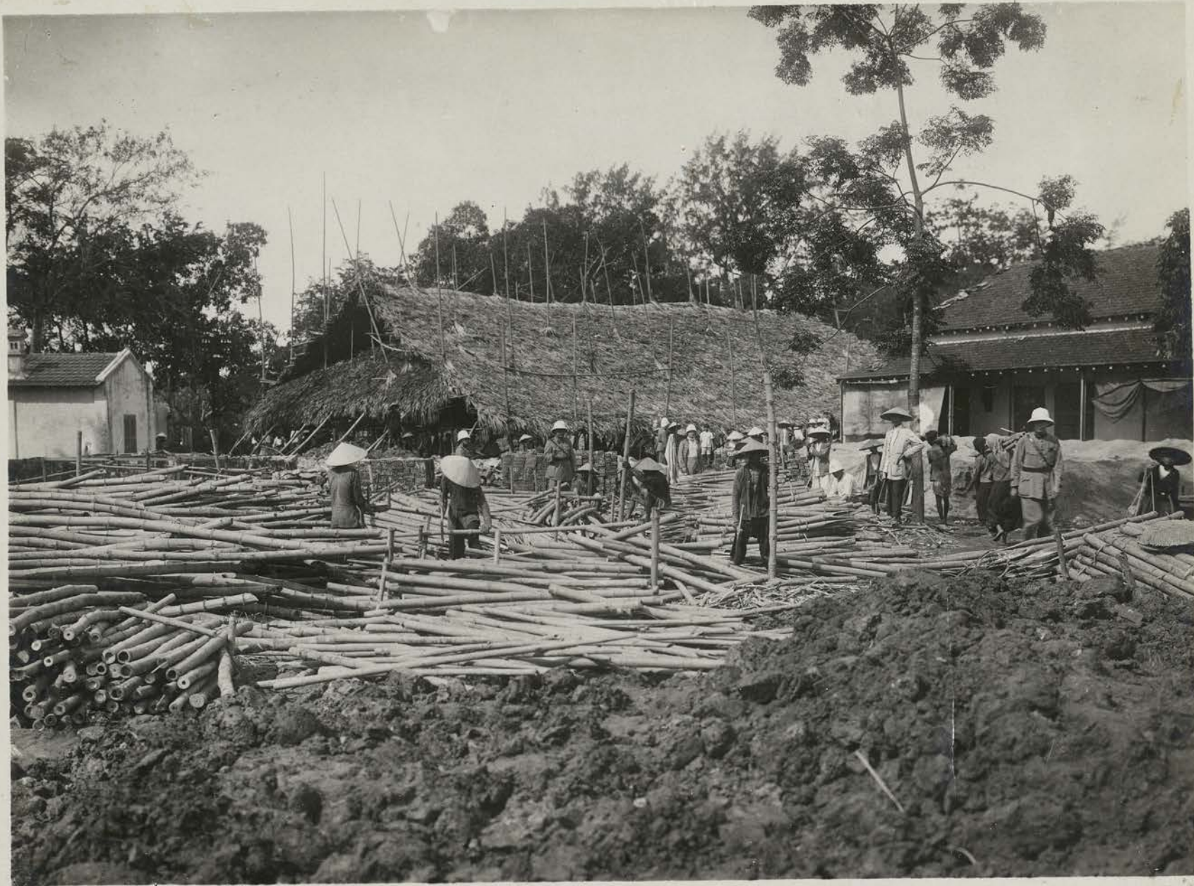
Une VASTE PAILLOTTE abrite le travail 4 des Fondations pendant la saison des Pluies.
