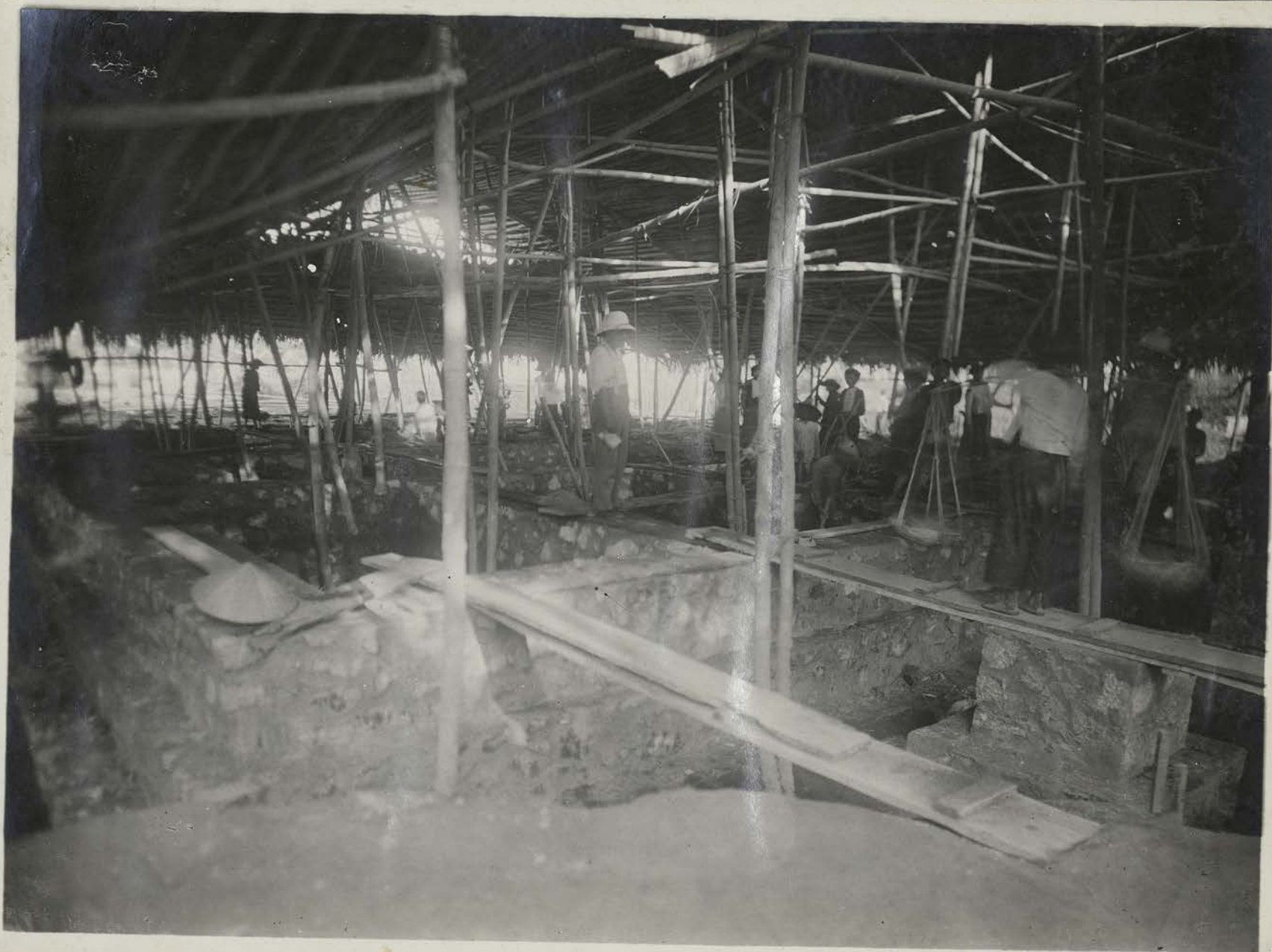
700 TONNES de maçonnerie - qui seront cachées au dessous du niveau du sol - constituent avec les Caicongs, les Fondations du Batiment .
