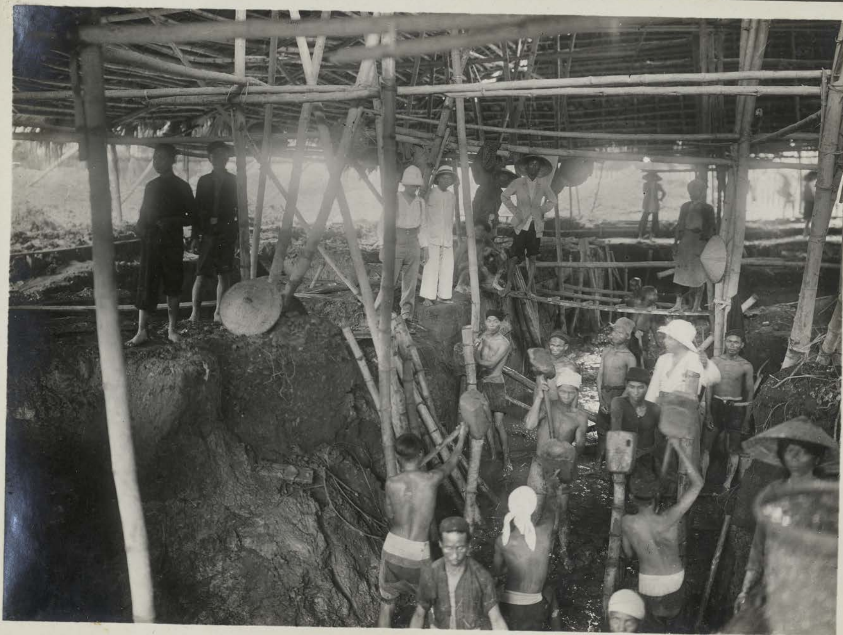
SOUS la PAILLOTTE : L'enfoncement des "caicongs" (BAMBOUS mâles de 8 à 10 cm de diam. et env. 2m de long.)
