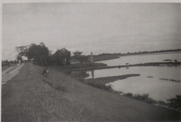
Digue du Day, septembre 1953.- La digue à hauteur de Yên Lô. 1/2
