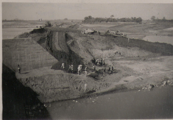
Barrage du Dai, juin 1950.- Les travaux.
