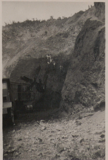
CAM PHA, juin 1950.- Col des Cerfs, charbonnages du Tonkin. Déblaiement et terrassement dans le charbon.
