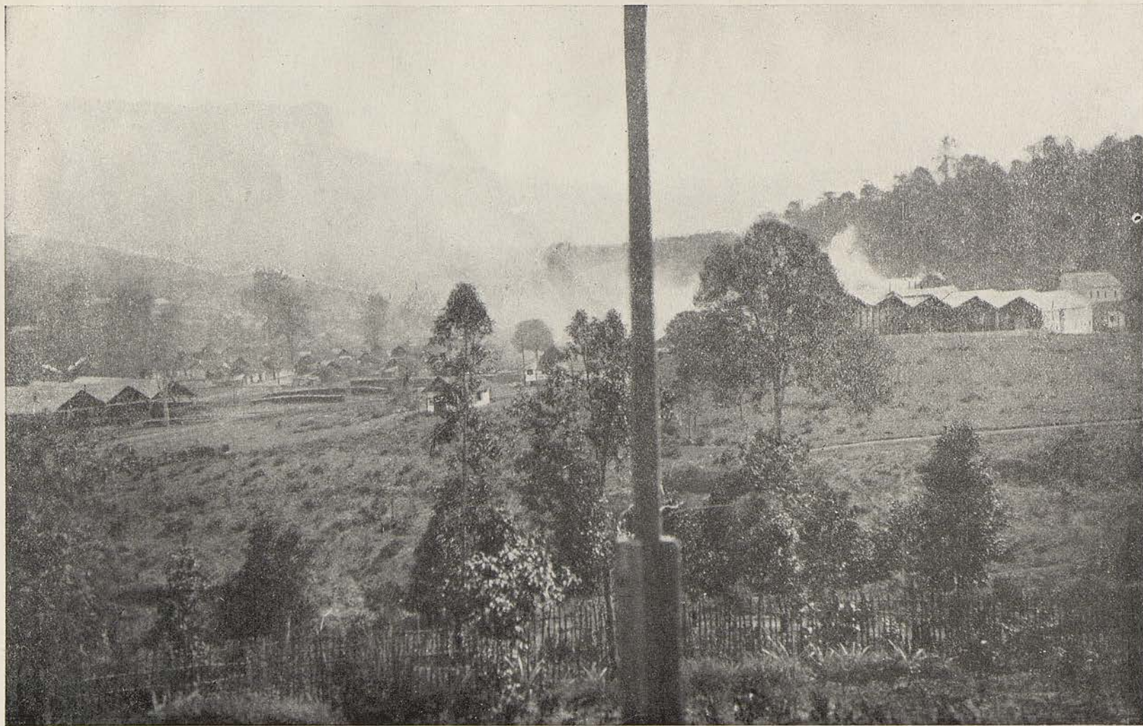
Vue générale de quelques installations de la SEEMI.
