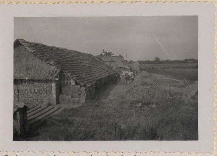
Briquetterie aux abords de la Route circulaire, près de Thinh Quang (S-O de Hanoi).- septembre 1953.
