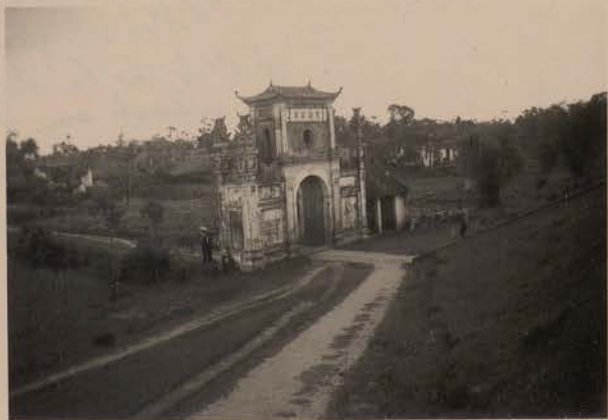
Portique d'entrée d'un village à l'est de la digue allant au village des Cocotiers, mai 1952.
