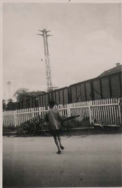
HANOI, septembre 1951.- Passage d'un train au Passage à Niveau de la Route Mandarine.
