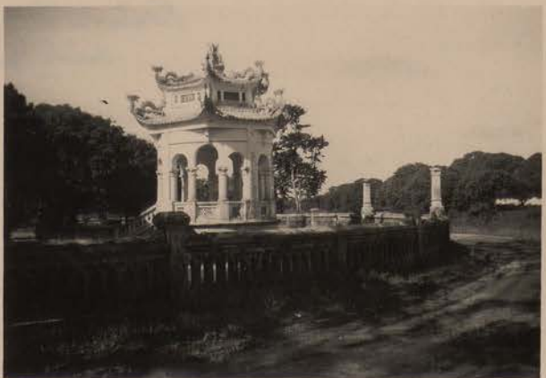
Route du Village du Papier. Site intérieur du village de Dong Xa.
