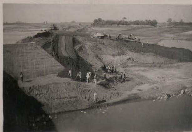
Barrage du Dai, juin 1950.- Les travaux.
