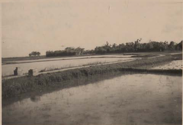
Route au S-E de HA DONG, juin 1952.- Piste d'accès au village de Xa La.
