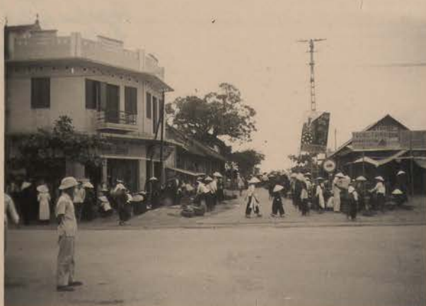
Route de HA DONG, juin 1952.- Carrefour de la route de Ha Dong à Nam Dong.
