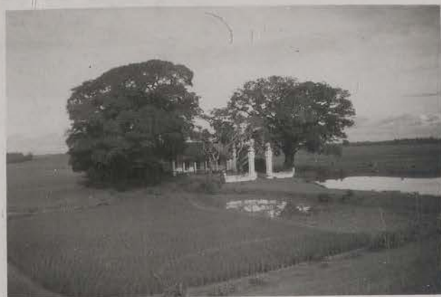
Digue du Day, septembre 1953.- Vue sur un den dans la rizière (à hauteur de Ha Dong).
