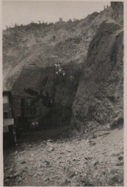
CAM PHA, juin 1950.- Col des Cerfs, charbonnages du Tonkin. Déblaiement et terrassement dans le charbon.
