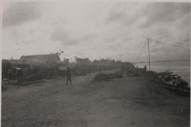
SON TAY, août 1953.- Vue sur la digue et le Fleuve Rouge vers l'amont.
