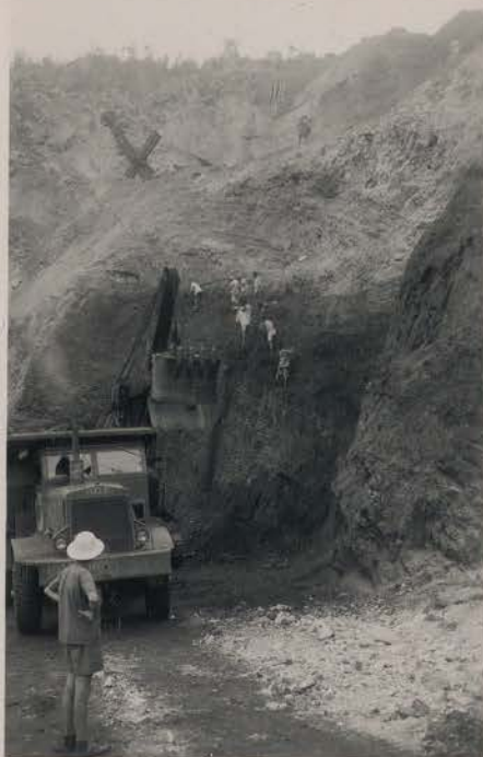
CAM PHA, juin 1950.- Charbonnages du Tonkin, terrassements du Col des Cerfs.(Cl. Robequain)
