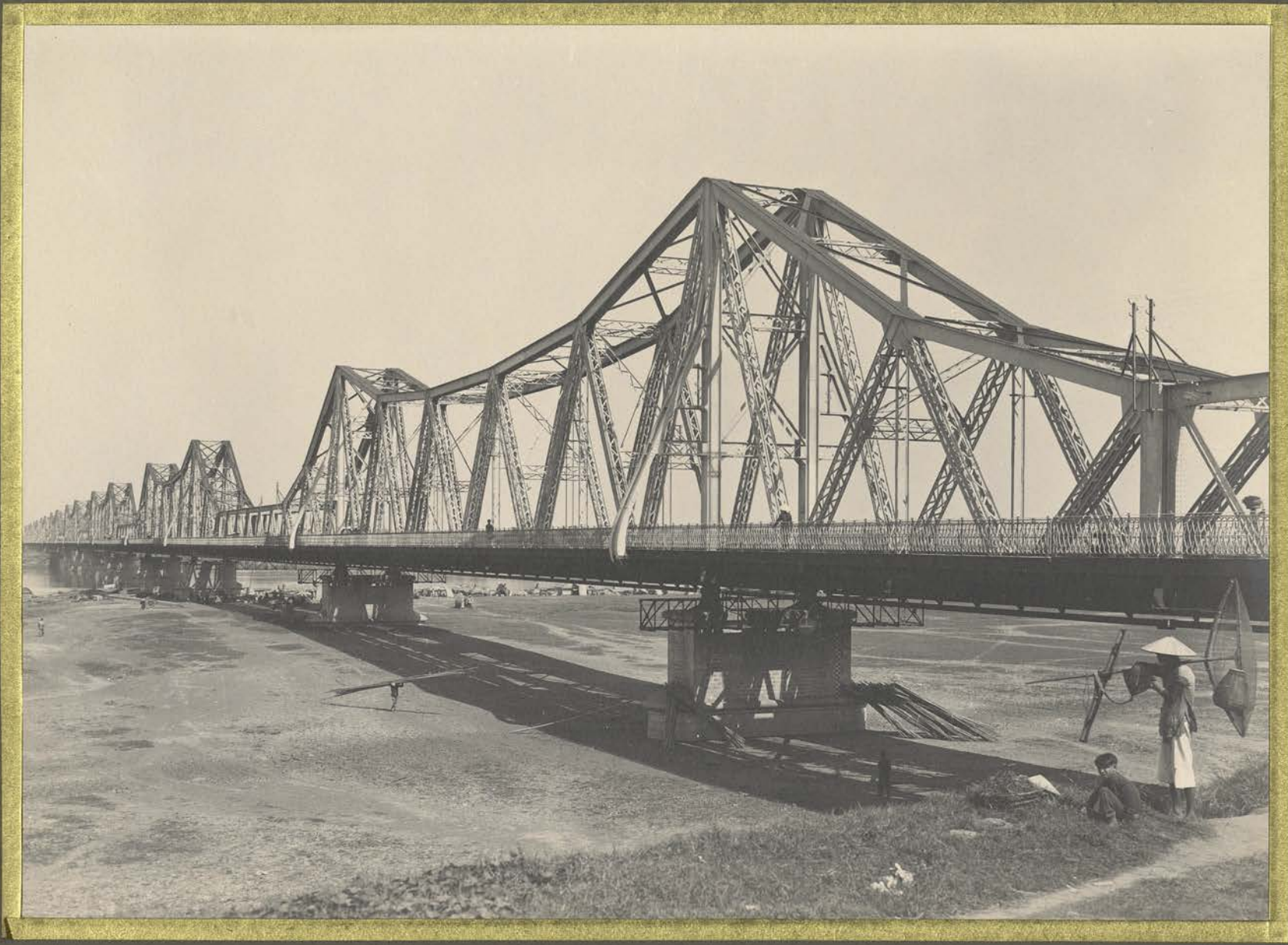
Hanoi. Le pont Doumer.
