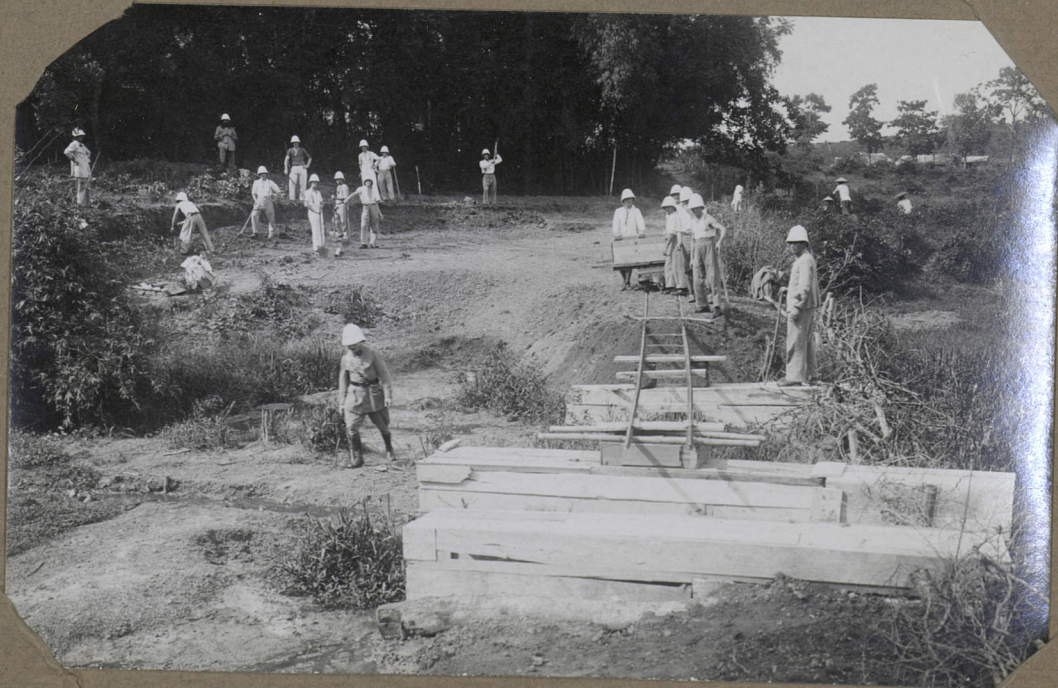
Tong. - Travaux de défense.
