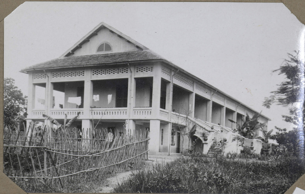
Tong. - Logement des sous-officiers mariés.
