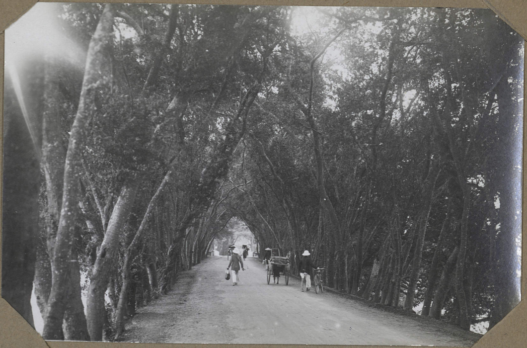
Tong. - La route à l'entrée du camp
