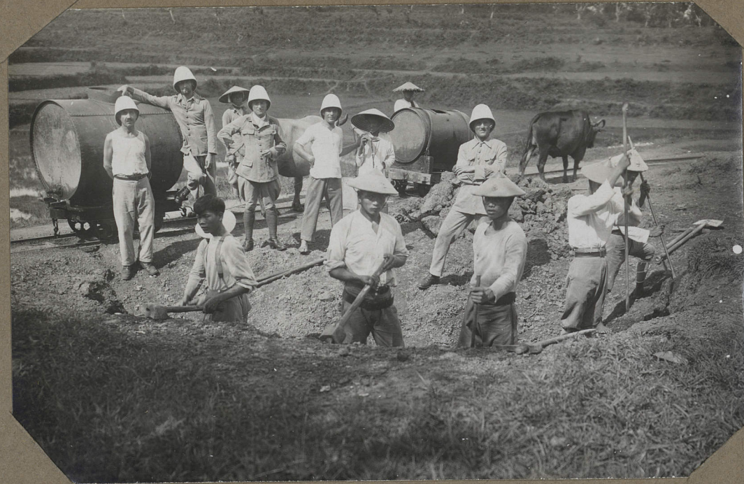
Tong. - Travaux à la voie ferrée
