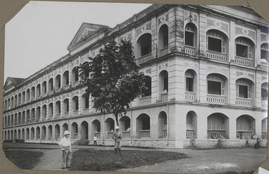
Tong. - Le bâtiment des 15 e Cie, C.M.4 et S.H.R.
